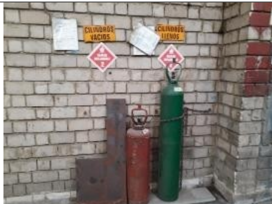
Foto 33. Área de almacenamiento de cilindros. Detalle de cilindros de gas inflamable vacío y lleno.
