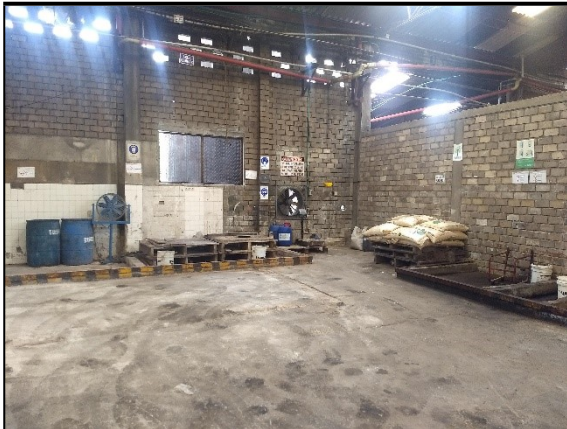
Almacén de producto químico
