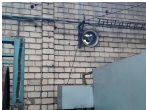
Foto 37. Componente atmosférico. Detalle de extractores encontrados en la planta.
