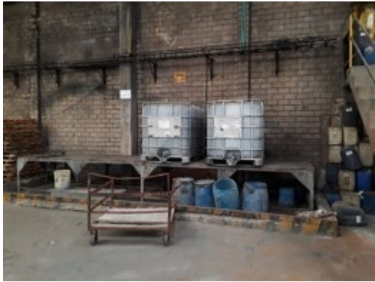
Foto 42. Tanques de cromo recuperado por la planta de tratamiento de aguas residuales.
